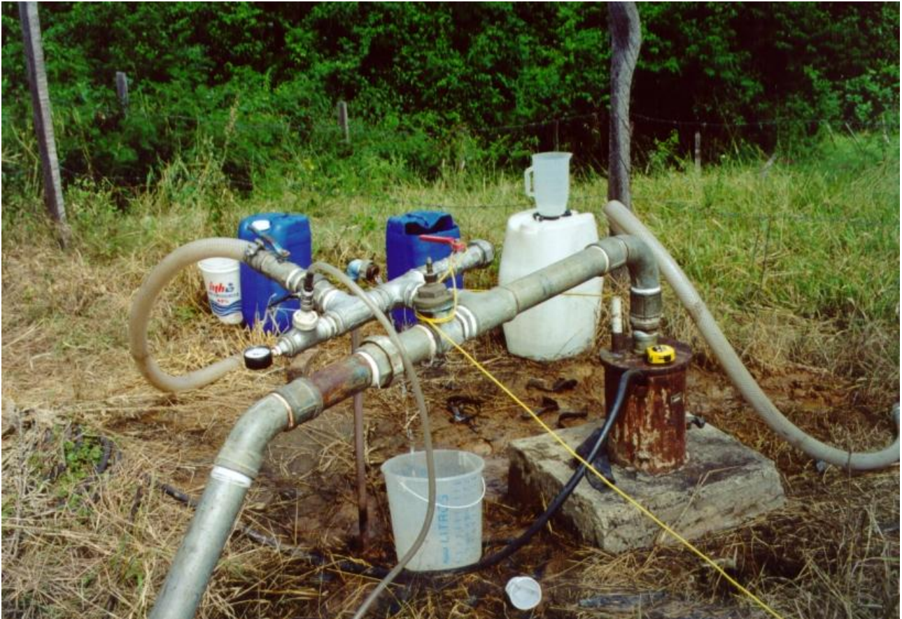
Figura 8. Dispositivo utilizado para circulação do fluído no poço Batistella II.
