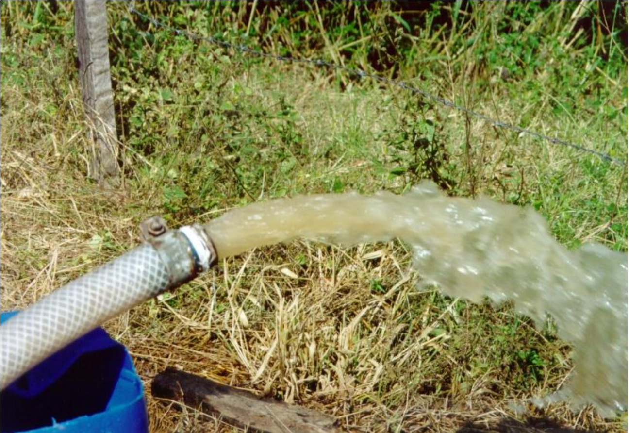
Figura 9. Solução descartada após a circulação, de cor amarronzada devido à presença de Carbonatos de Cálcio, Ferro e Manganês dissolvidos.
