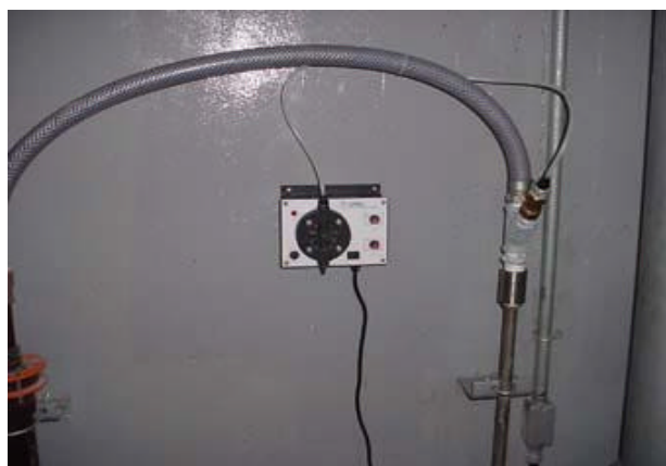
Figura 5: Ponto de aplicação do produto – UHE FCE.
