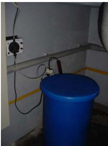
Figura 4: Ponto de aplicação do produto - UHE GPS.
